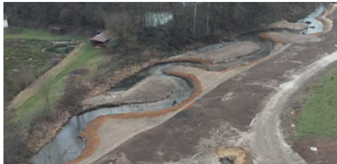
Drohnaufnahme der Maßnahme unterstrom der Brücke unmittelbar nach Fertigstellung vom Dezember 2025.
