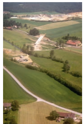
Staatsstraße 2119 und Kläranlage im Bau – Luftaufnahme von Donatus Moosauer 1975.
