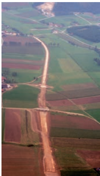
Staatsstraße im Bau 1975, die beiden Brücken bei Buch werden errichtet, die Trasse geht vorerst bis Isarhofen, im Hintergrund die Berger Asphalt-Mischanlage.
